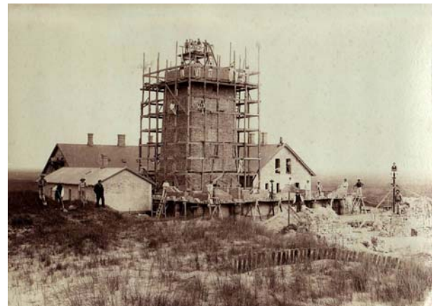
Fyret under opførslen i år 1900 - over 30 mand står på stillads i vinduer på tag mv
